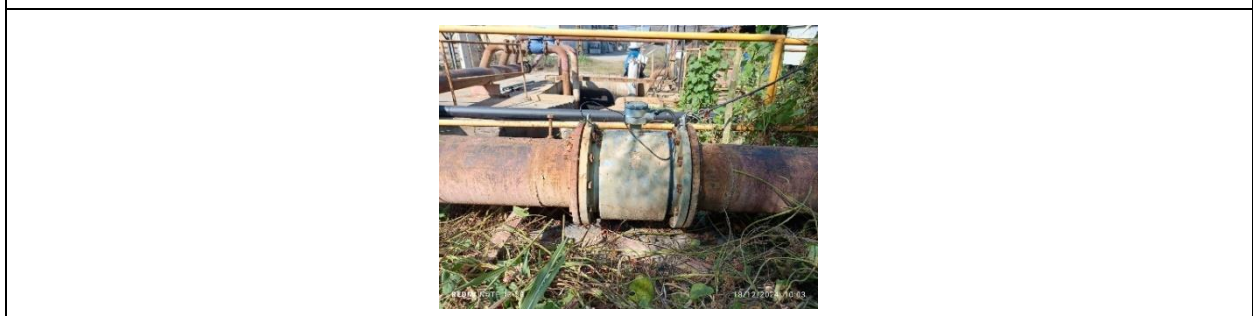
รูปที่ 31 มิเตอร์ตรวจสอบปริมาณน้ำเสีย
